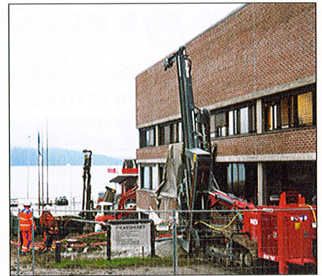
Kjølinga skal skje ved hjelp av fjellbrønner, og det vert no arbeidd med å bore slike rundt fylkeshuset.
